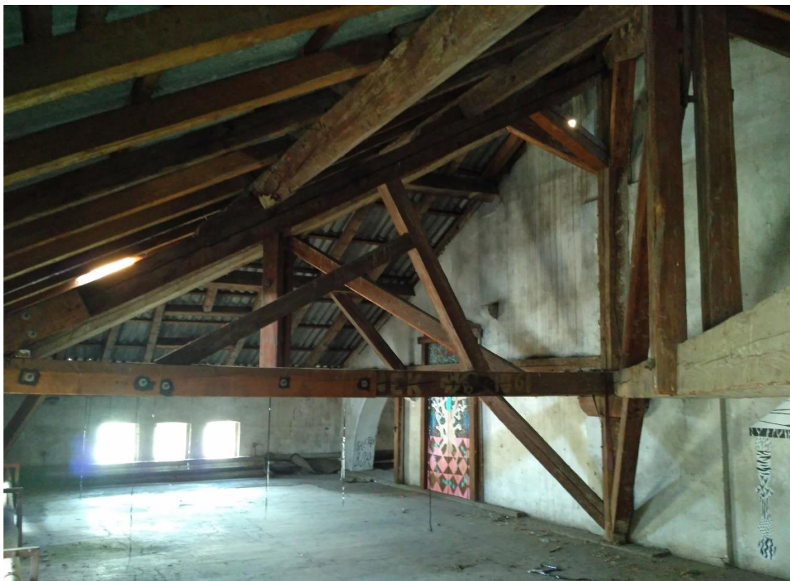
Slika 8. Konstrukcija potkrovlja dvorišne zgrade
